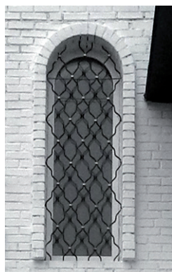
Миасский городской округ, пос. В. Атян, ул. Центральная, 18
